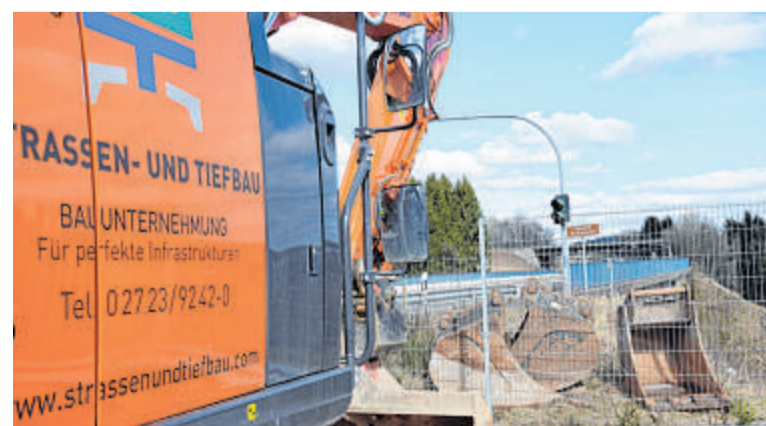
Straßen- und Tiefbau aus Kirchhundem steht mit den ersten Baggern schon in den Startlöchern, Anfang April soll das Bauprojekt beginnen. FOTO: JOSEF SCHMIDT
