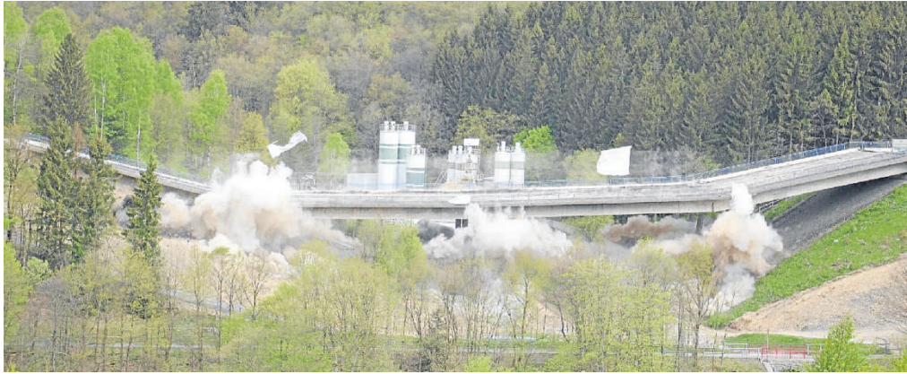
Die zwölf Brückenpfeiler knickten ein, genau wie Sprengleiter Michael Schneider zuvor angekündigt hatte.
