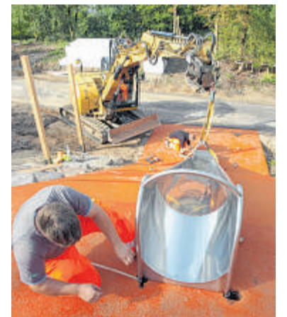
Die Montage und das Ausrichten der acht bis zehn Meter langen Rutschen im Hang des Haldengartens ist echte Millimeterarbeit.
