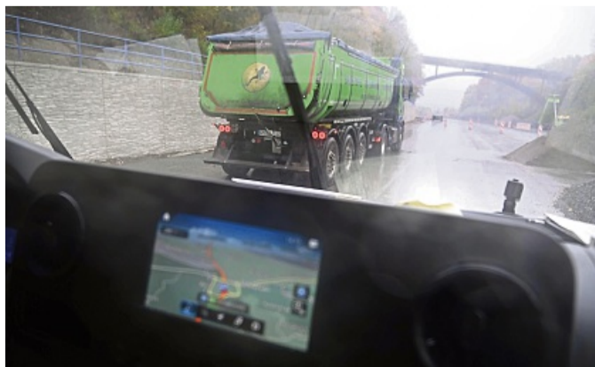
Innen- und Außenansichten der laufenden Asphaltierungsarbeiten im Lüdenscheider Norden.
