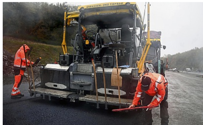
Auch im Nieselregen gingen die Arbeiten am Montag im nächsten Abschnitt weiter.
