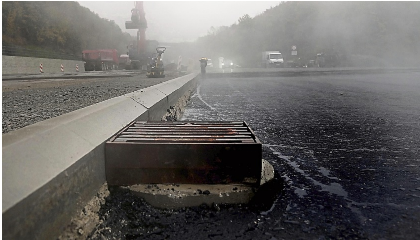
Eine zwölf Zentimeter dicke erste Tragschicht ist aufgetragen, doch weitere 24 Zentimeter in drei Schichten folgen, bis der Aufbau auch auf diesem Abschnitt fertig sein wird.
