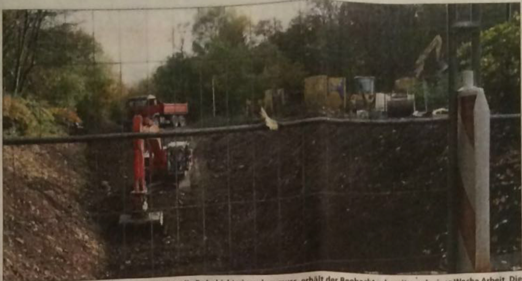
Eine Ahnung davon, wie tief der Bagger sich in die Erdschicht eingraben muss, erhält der Beobachter bereits nach einer Woche Arbeit. Die Hälfte der zehn Meter ist geschafft. Abgesichert werden die Seiten später durch meterhohe Stützwände. • Fotos: Kornau
