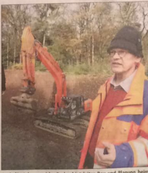
Auch für Johannes Irl, Sachgebietsleiter Bau und Planung beim Stadtentwässerungsbetrieb, sind die Arbeiten oberhalb des Saunadorfes keine übliche Baustelle. Zehn Meter tief gräbt sich der Bagger hier ins Erdreich, um das marode Rohr freizulegen.
