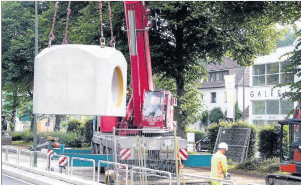
Der Hauptsammler am Haken des Baukrans. Die Kanalsanierung in der Altenaer Straße macht große Fortschritte und kann eher beendet werden als geplant. ■ Fotos: Messy
