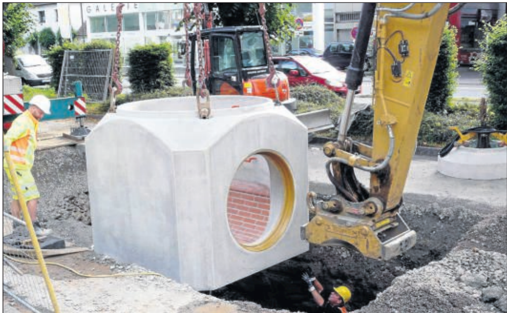
Beim Einbau ist Präzision gefragt. Der Bagger schiebt den Sammler vorsichtig in die richtige Position, unten wird auch ein wenig Menschenhand angelegt.
