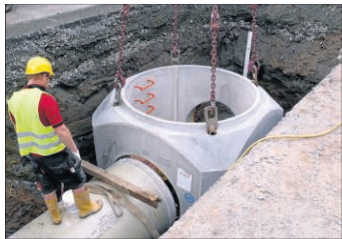
Maßarbeit: Der Sammler wird direkt zwischen den bereits verlegten Rohren eingepasst.
